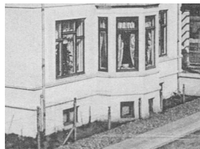
Kælderen i Stormgade.
